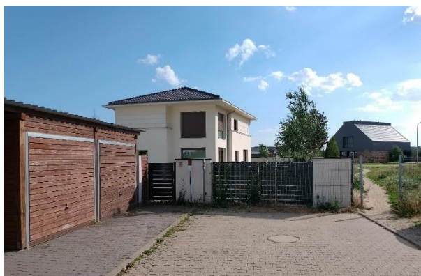
Fot. 9. Ślepe zakończenie ul. Oliwnej – brak możliwości przejazdu na zewnątrz osiedla.
