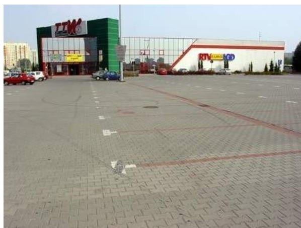
Fot. 8. TTW Dom i Ogród, 2002
