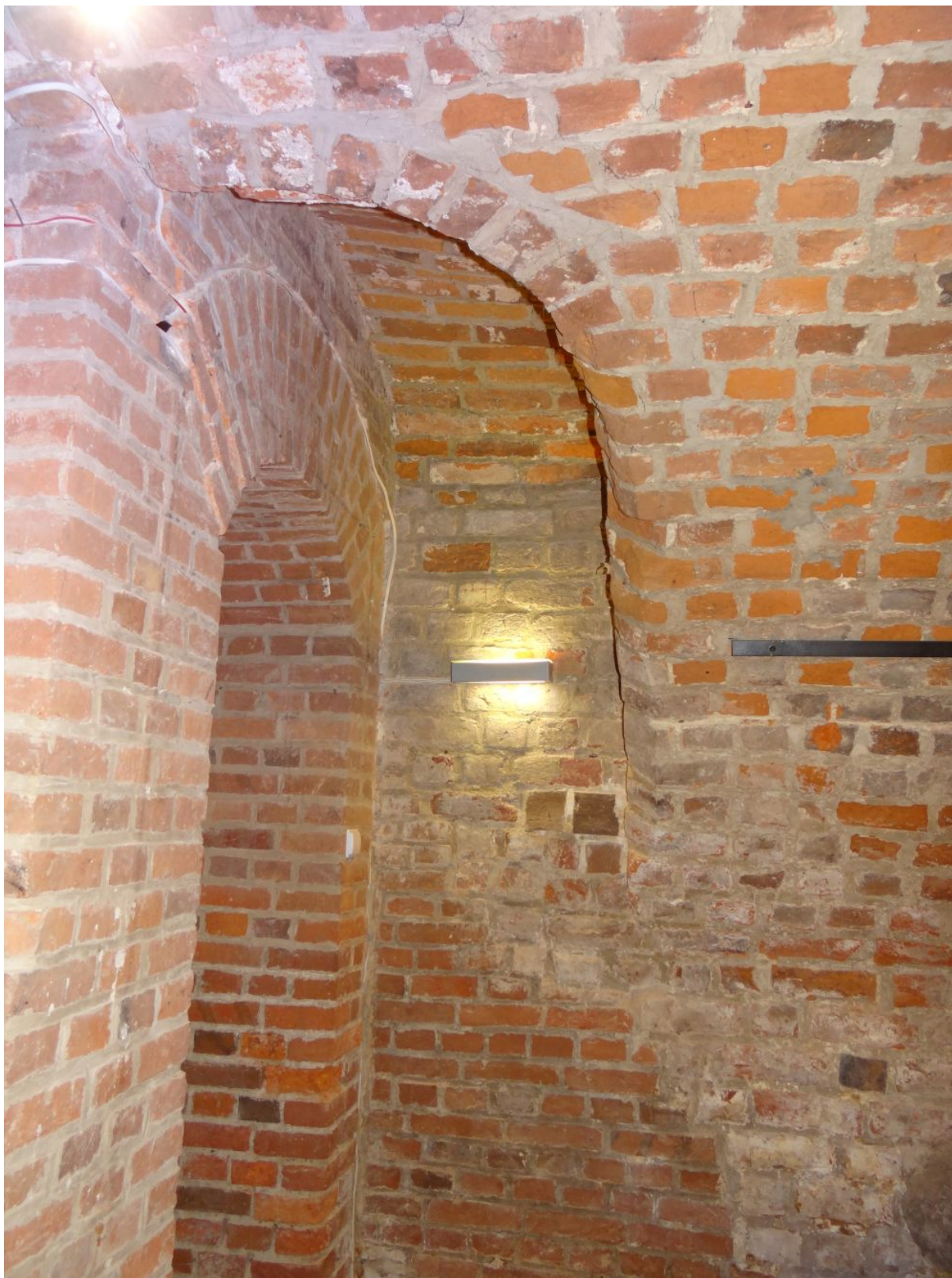
19. Kórnik, zamek, najniższa kondygnacja (tzw. piwnice), pomieszczenie P8 (narożnik południowo-wschodni), łuk schodów, stan z 2017 r.
