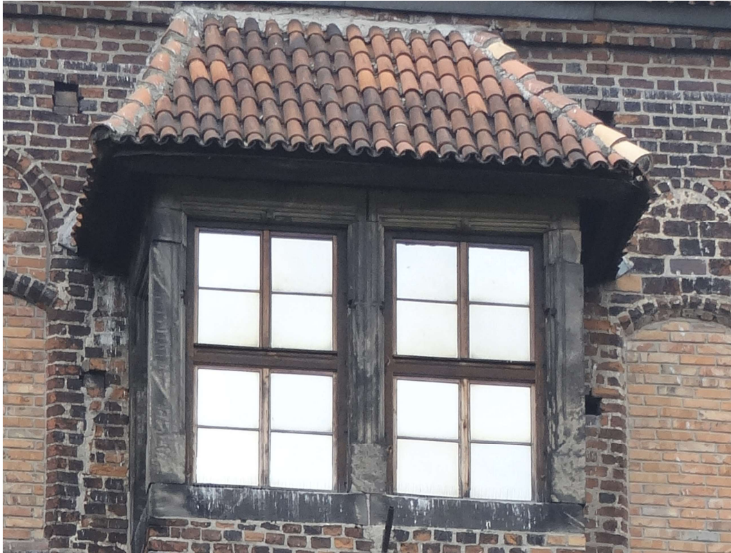
103. Szamotuły, baszta, III p., wykusz płd., obramienie okienne, ok. 1518, piaskowiec, stan z 2022 r.
