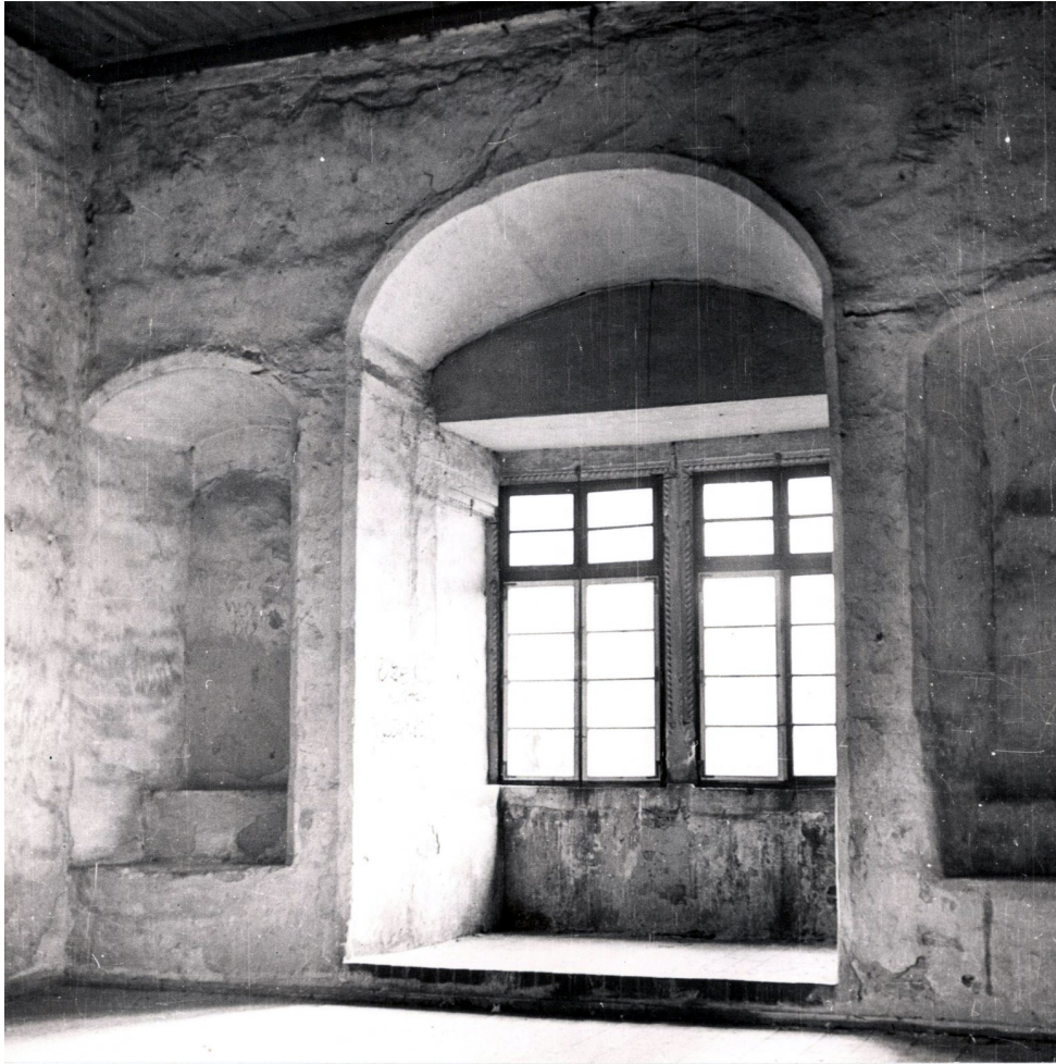
101. Szamotuły, baszta bramna, III p., ściana południowa, wnęka okienna z dekoracją z piaskowca, po bokach okna zamieniona na nisze ścienne, stan z 1941 r.
