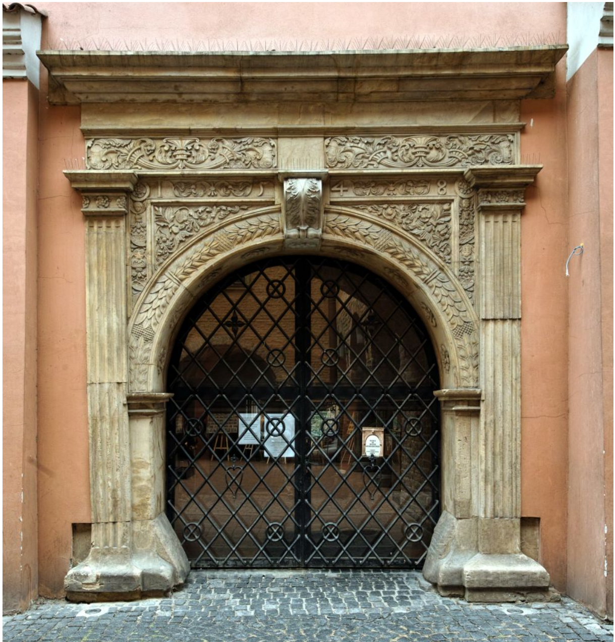
202. Poznań, pałac Górków, portal w elewacji wschodniej (przy ob. ul. Klasztornej), 1548, stan z 2022 r.
