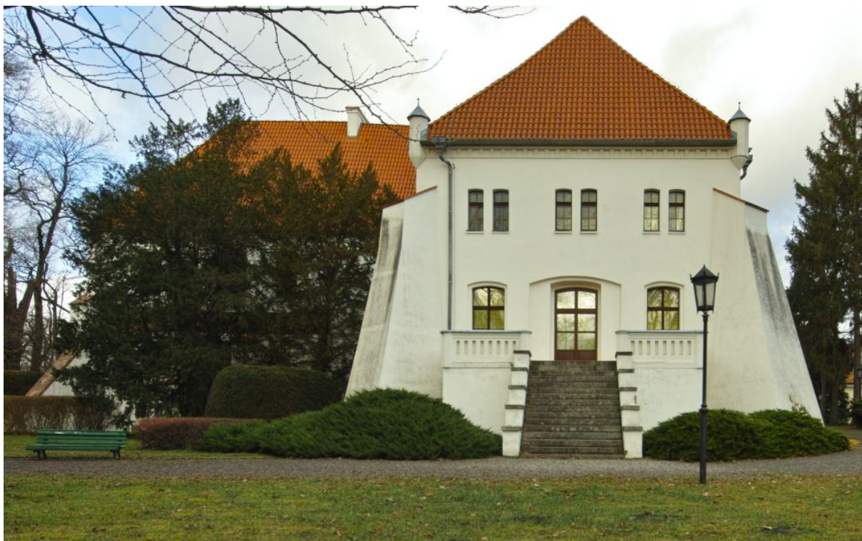
109. Szamotuły, pałac, elewacja południowa skrzydła wschodniego, stan z 2023 r.
