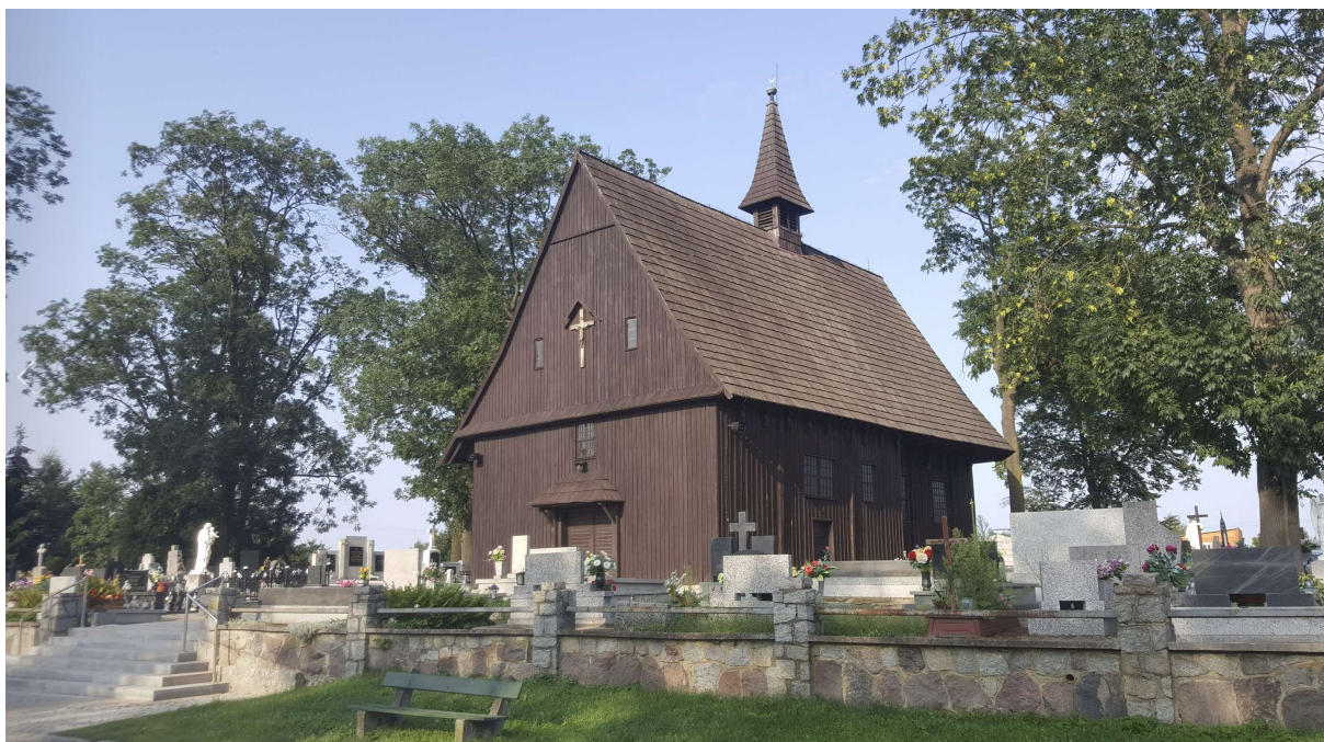
154. Koźmin Wlkp., kościół cmentarny pw. św. Trójcy (1570), stan z 2017 r.
