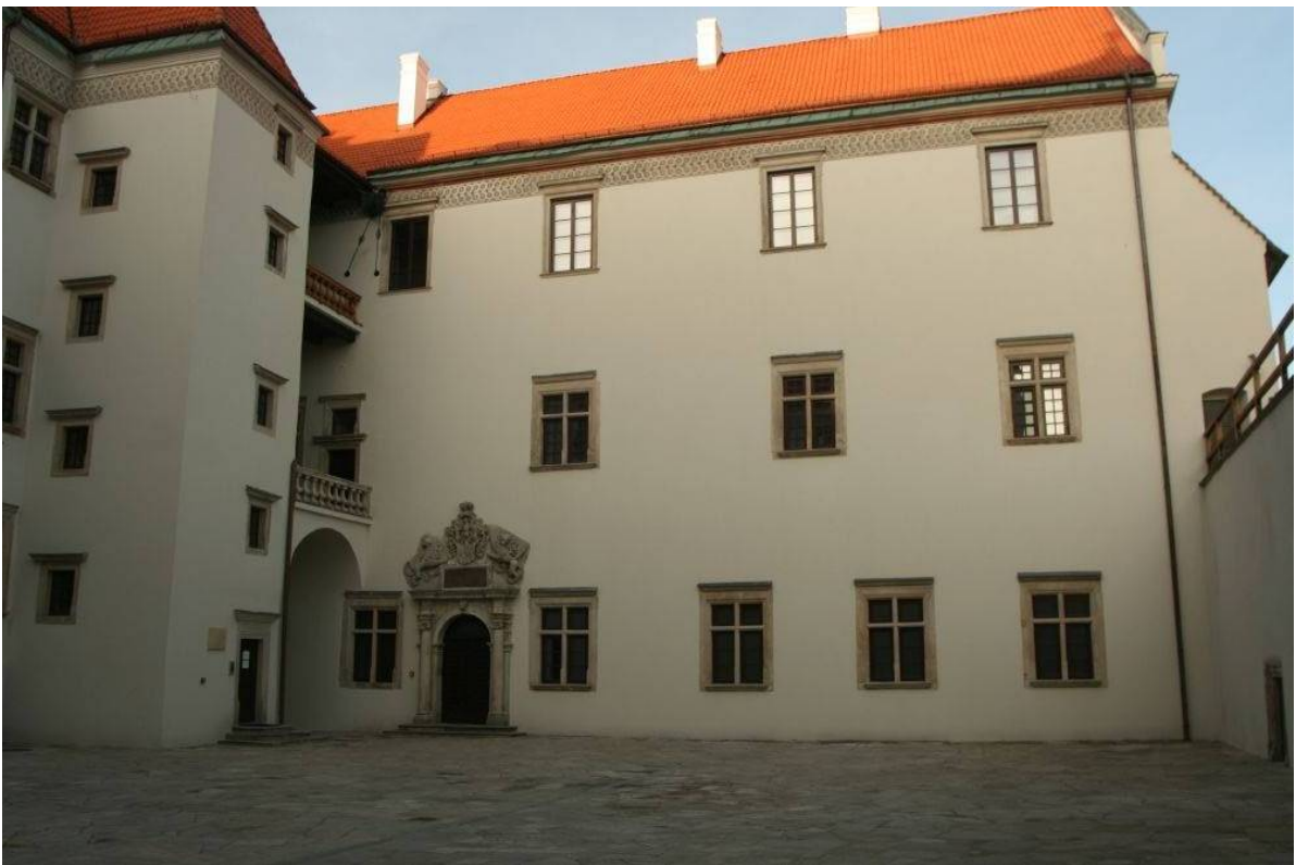
252. Szydłowiec, zamek, dziedziniec, narożnik północno-wschodni, stan współczesny.
