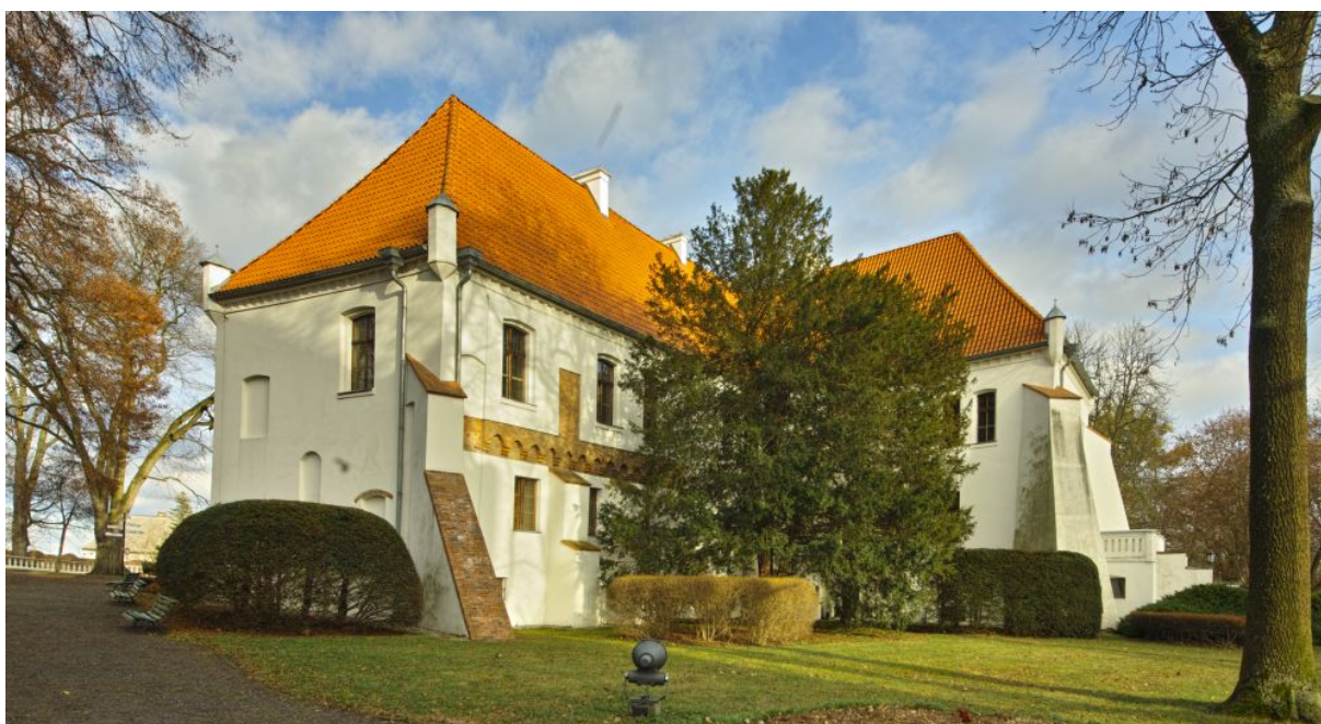
110. Szamotuły, pałac, narożnik południowo-zachodni skrzydła północnego, stan z 2023 r.
