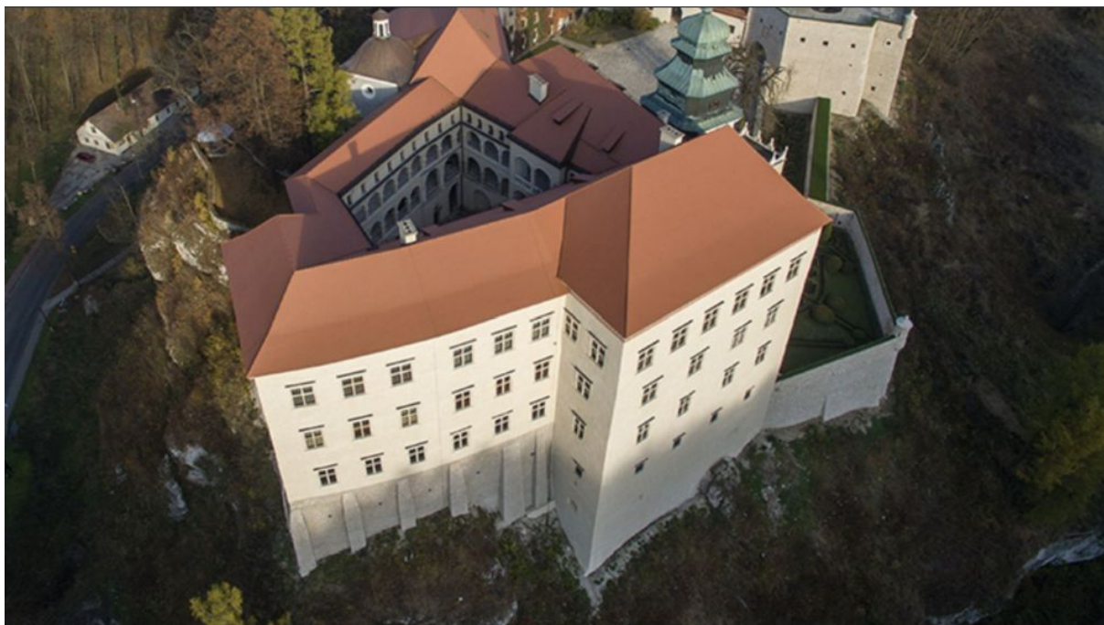
274. Pieskowa Skała, zamek, widok z południowego-zachodu na północną ścianę zamku, stan stan współczesny (po renowacji z l. 2014-2016).
