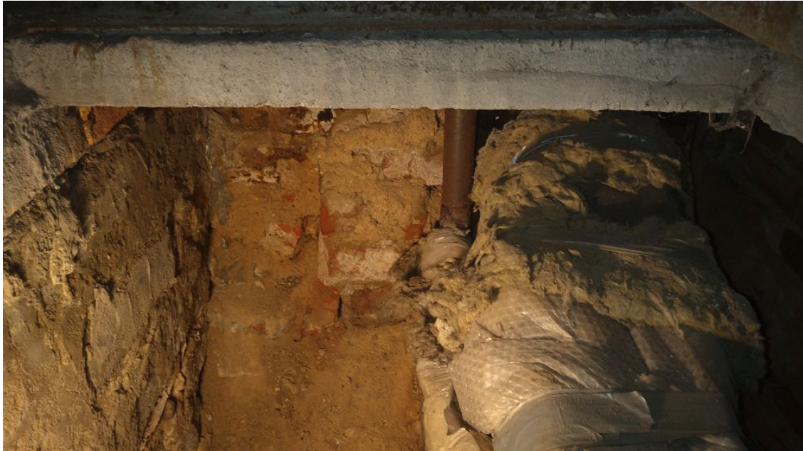
118. Szamotuły, pałac, ob. piwnice, pomieszczenie socjalne, rewizja centralnego ogrzewania, fragment ceglanoego muru z XV lub XVI wieku, stan z 2022 r.
