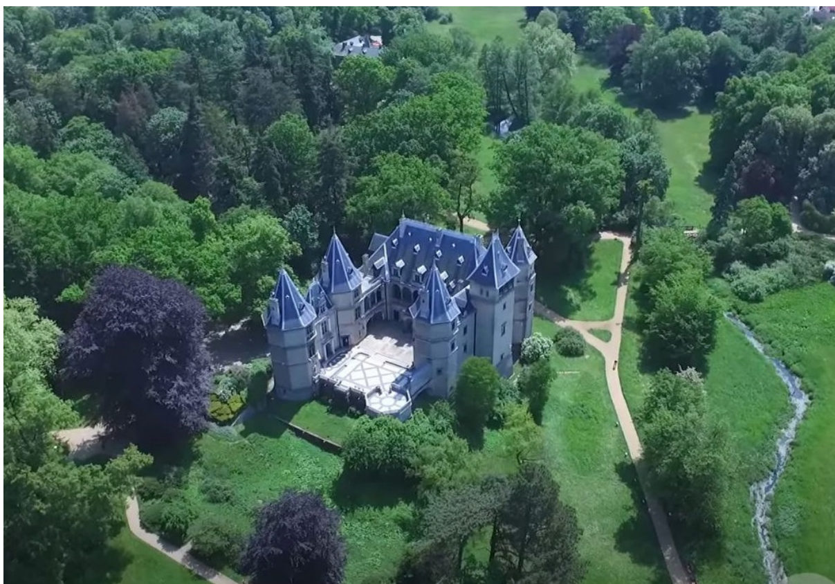
230. Gołuchów, zamek, widok z drona od północnego zachodnu, stan z 2016 r.
