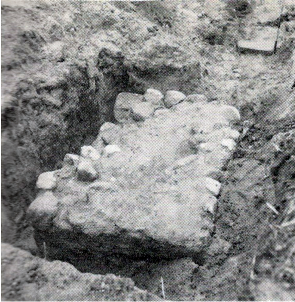
58. Mościenica k. Kórnik, fundamenty pawilonu myśliwskiego odkopanego przez archeologów w 1969 roku, fundament filaru na linii ściany południowej.
