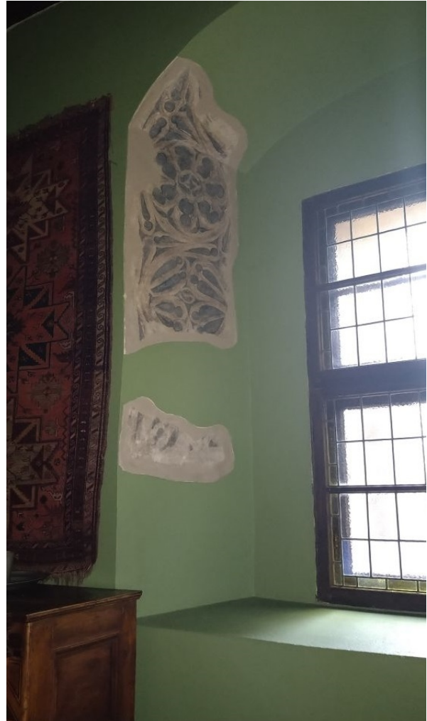
81. Szamotuły, baszta, I p., izba, ściana południowa, wnęka okienna z dekoracją malarską, stan z 2022 r.
