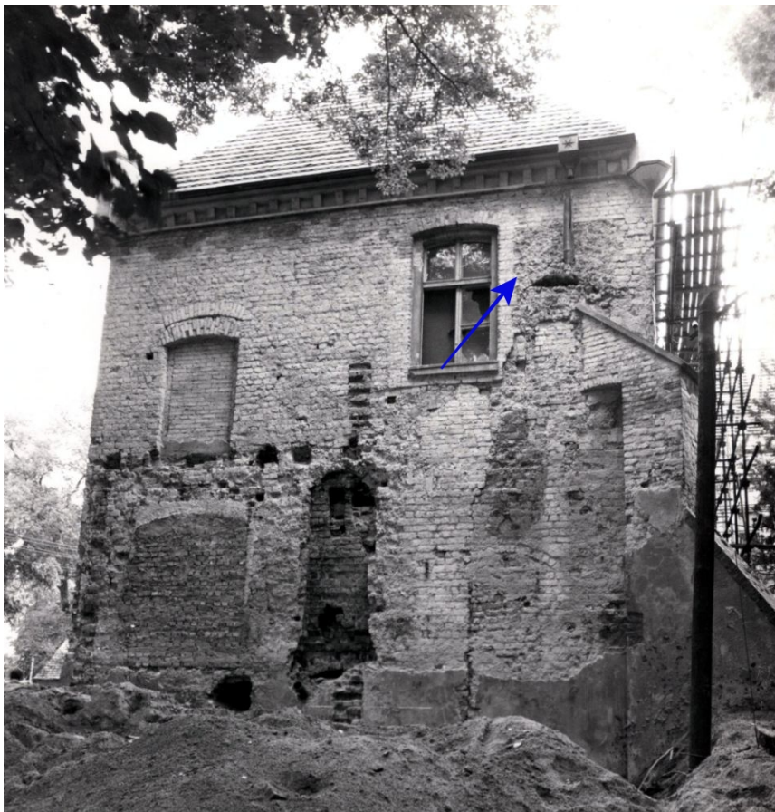
127. Szamotuły, pałac, elewacja zachodnia skrzydła północnego, stan po zdjęciu tynków podczas remontu w l. 80. XX w., z zaznaczeniem śladu po wykuszu ze schodami.
