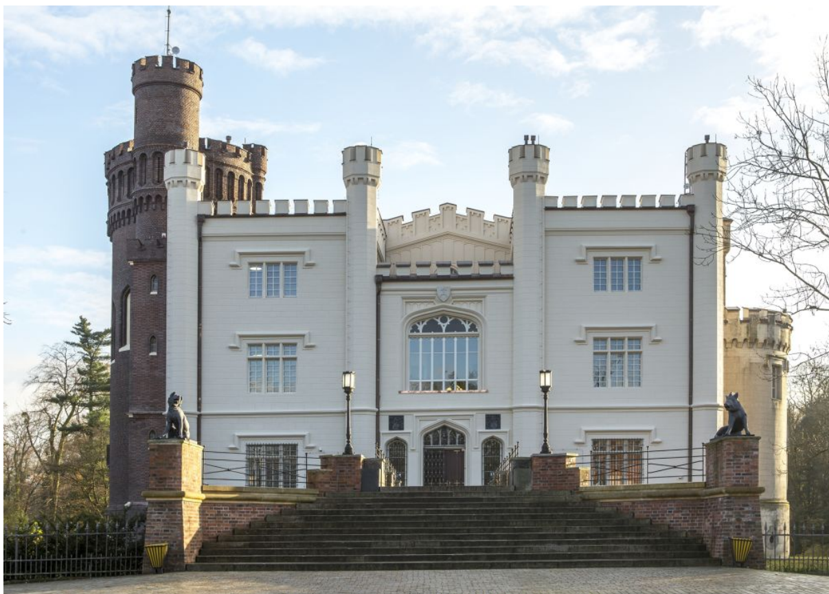
14. Kórnik, zamek, elewacja północna, stan z 2022 r.
