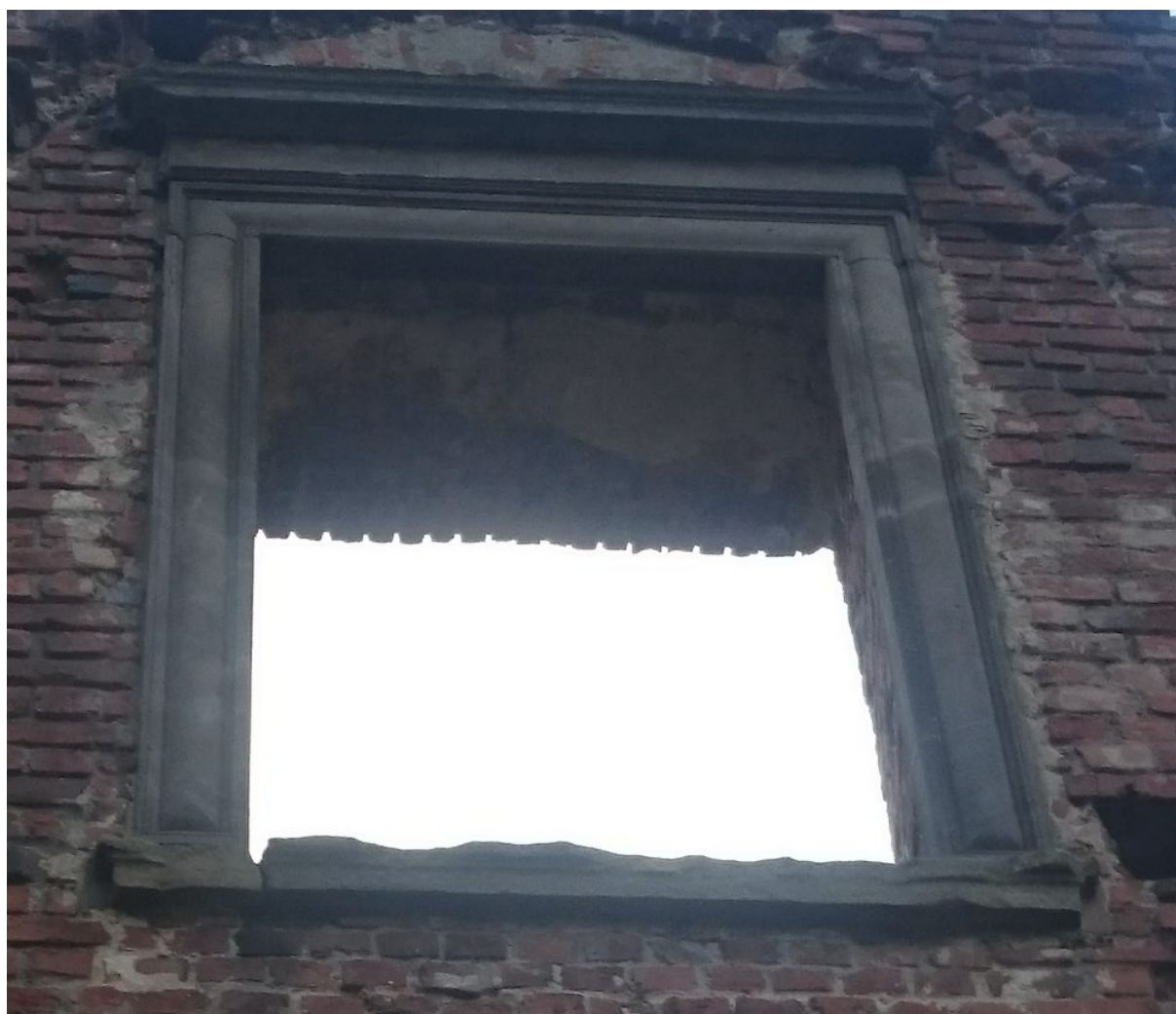
242. Radlin, zamek, obramienie okienne we wschodniej elewacji pałacu, stan z 2017 r.
