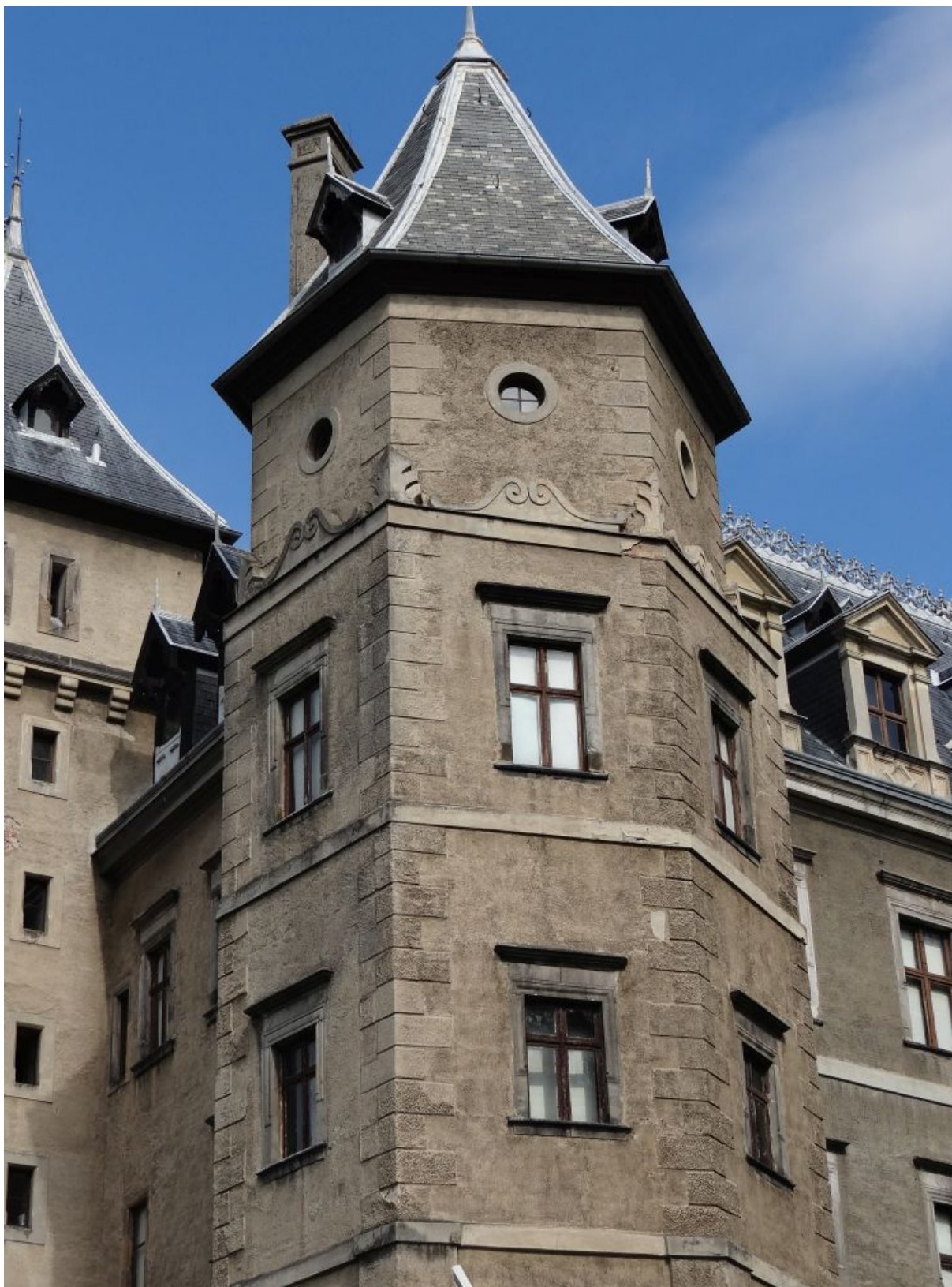
237. Gołuchów, zamek, fragment dawnej attyki wtopiony w nadbudowaną kondygnację wieży południowo-zachodniej, stan z 2019 r.
