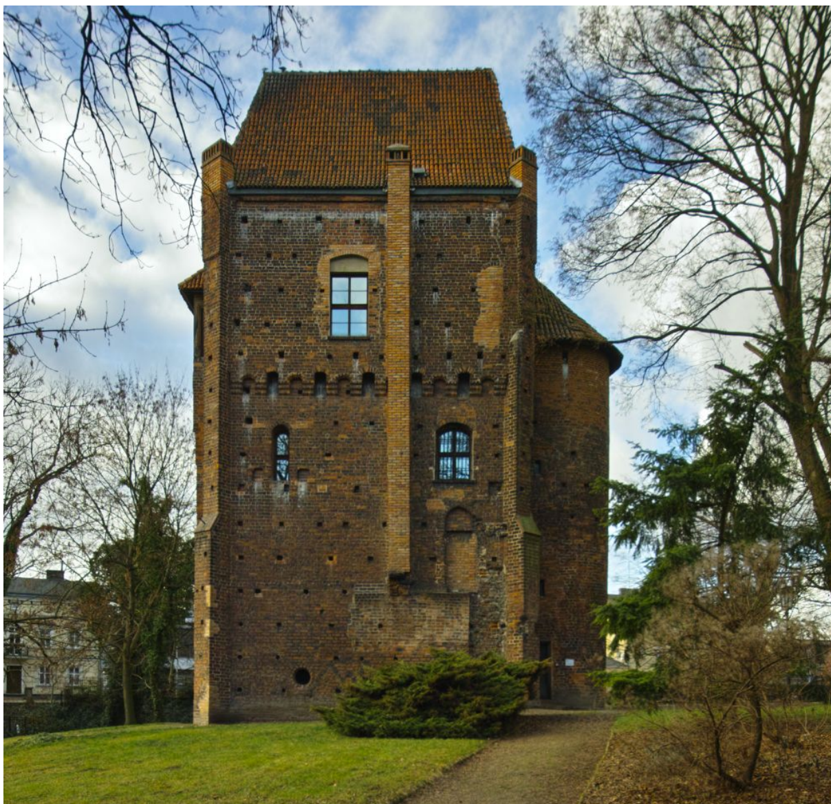
82. Szamotuły, baszta, elewacja wschodnia, stan z 2023 r.
