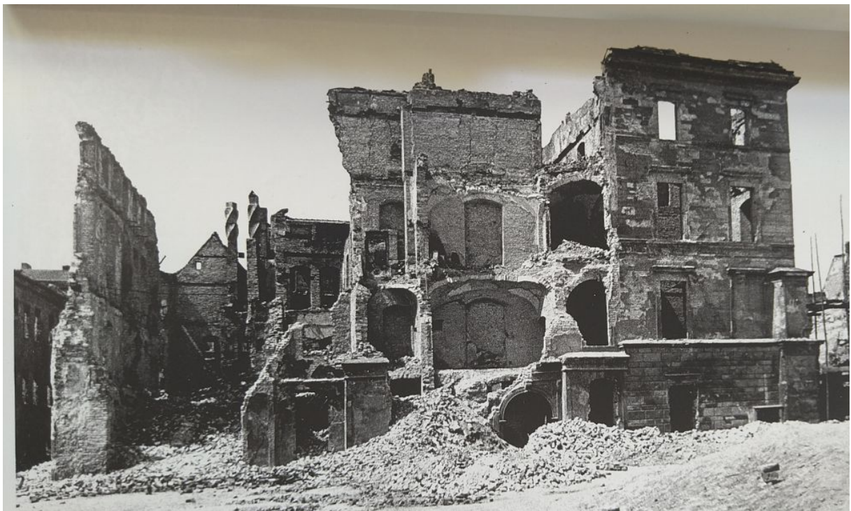
186. Poznań, ruina pałacu Górków ok. 1945 r., widok od wschodu.
