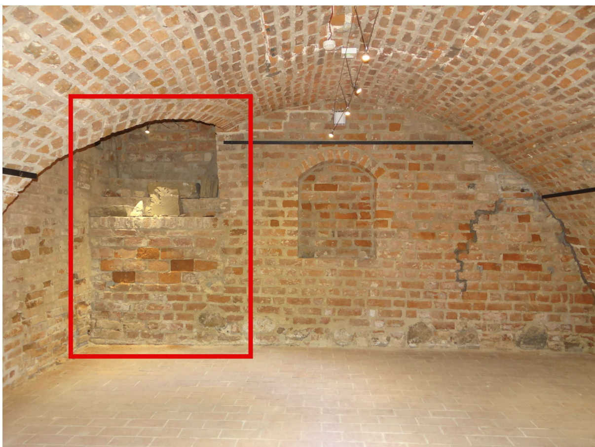
18. Kórnik, zamek, najniższa kondygnacja (tzw. piwnice), pomieszczenie P10 (ściana wschodnia), z zaznaczeniem zamurowanych schodów prowadzących na wyższą kondygnację, stan z 2017 r.
