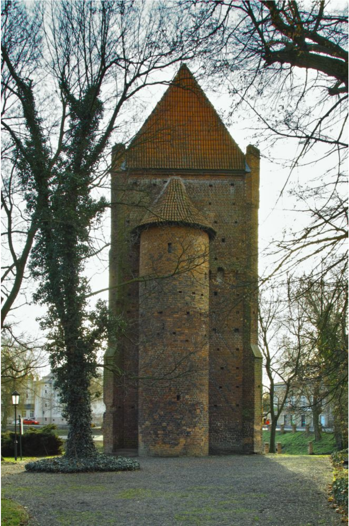
79. Szamotuły, baszta, elewacja północna z wieżą schodową, stan z 2023 r.
