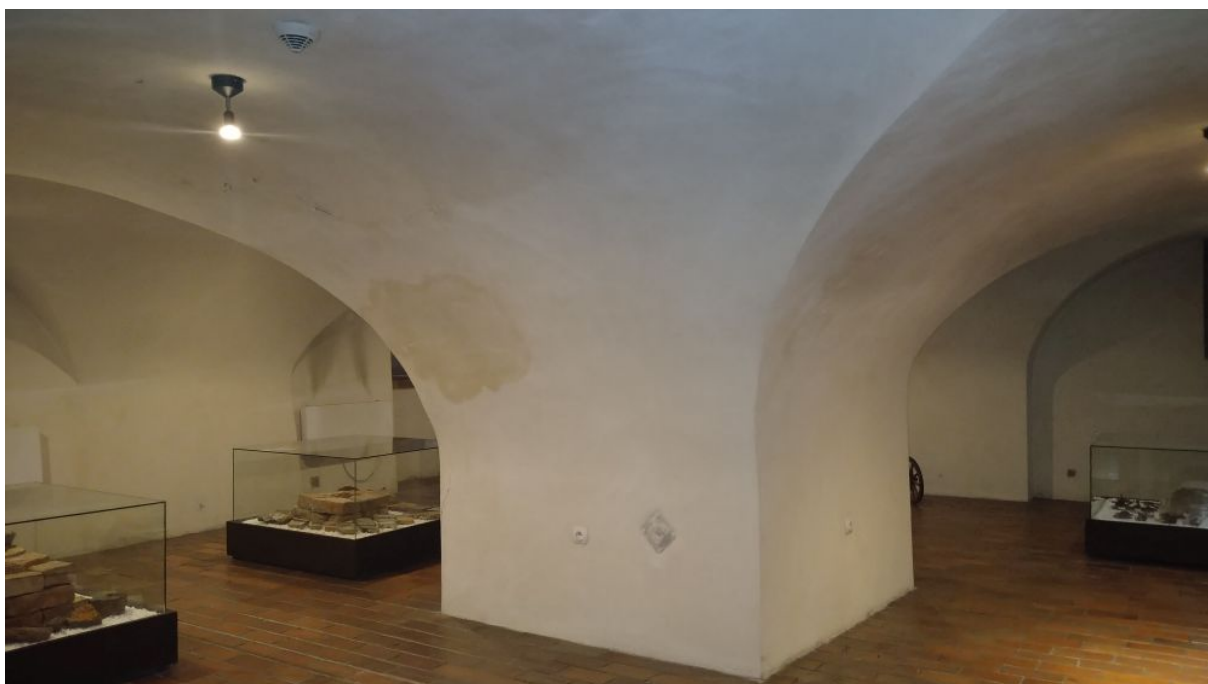
114. Szamotuły, pałac, skrzydło wschodnie, ob. tzw. druga kondygnacja piwnic (dawn. piwnice), sala z filarem, widok na południowy-wschód, stan z 2022 r.
