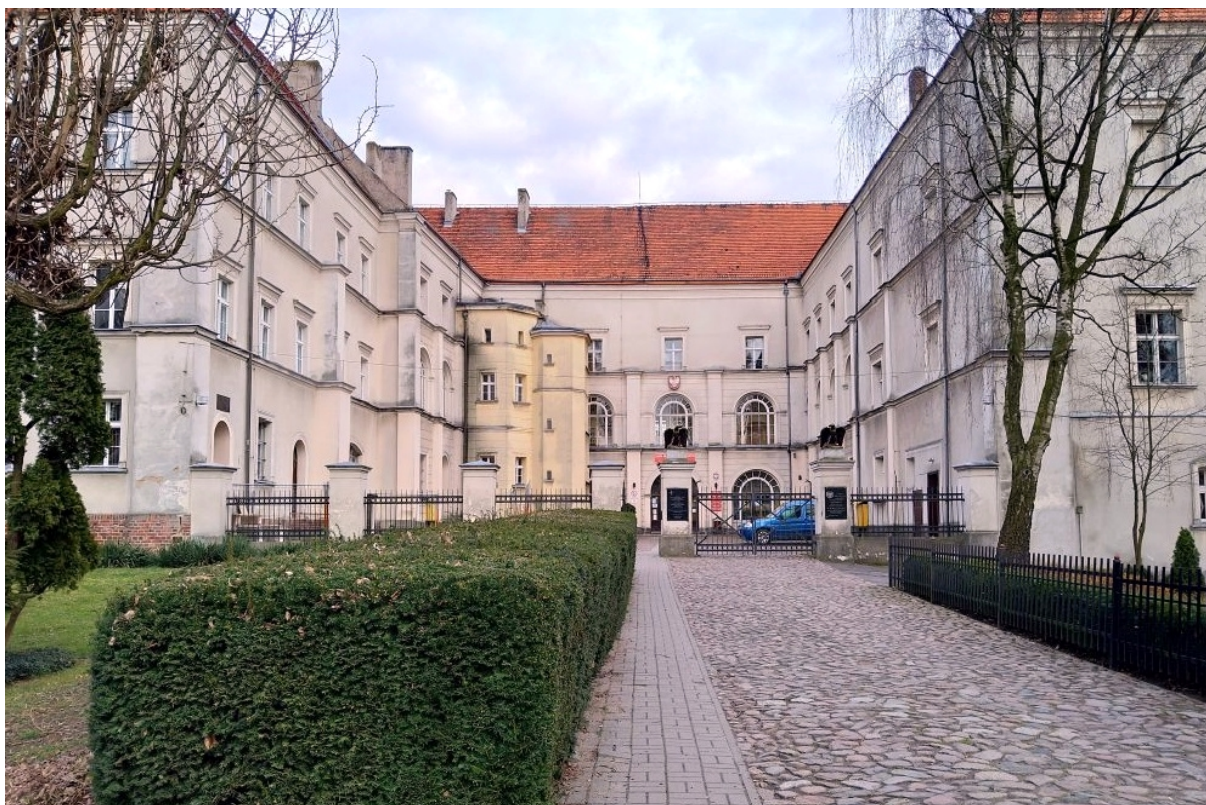
163. Koźmin Wlkp., zamek, widok na dziedziniec od strony zachodniej, stan z 2023 r.
