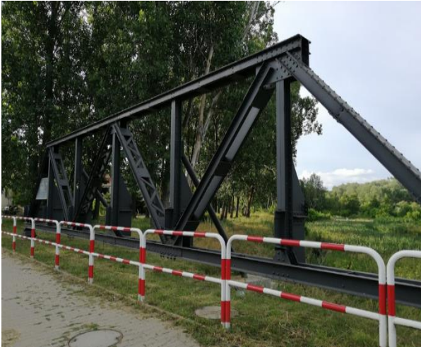
Fot. 56. Metalowe przęsła dawnego mostu Źródło: W. Terlecka, lipiec 2021.
