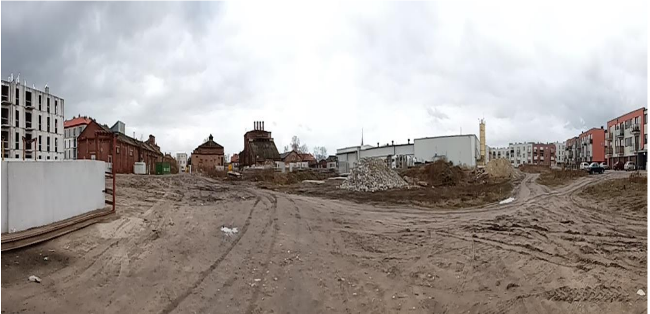
Fot. 46. Historyczna, niszcząca zabudowa postawiona w Luboniu przez spółkę C. A. Koehlmann z Frankfurtu nad Odrą w otoczeniu rozbudowywanego osiedla mieszkaniowego Źródło: W. Terlecka, luty 2023.
