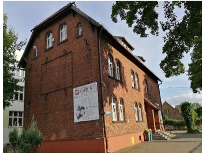
Fot. 63. Zabytkowy budynek szkoły Źródło: W. Terlecka, lipiec 2021.
