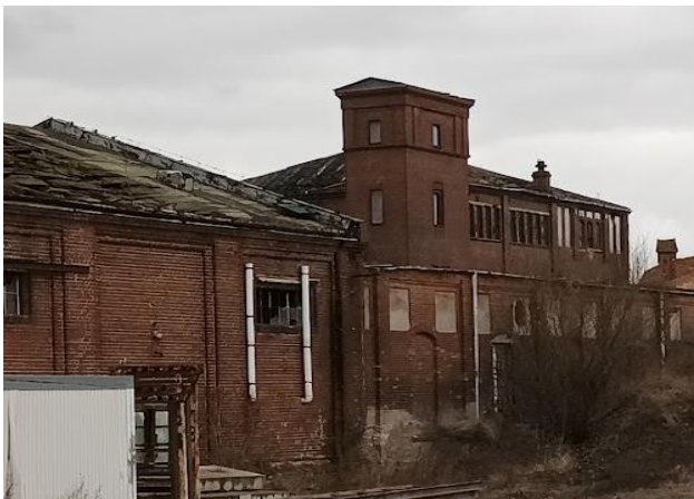
Fot. 50. Budynek suszarni mączki z wieżą próżniową Źródło: W. Terlecka, luty 2023.
