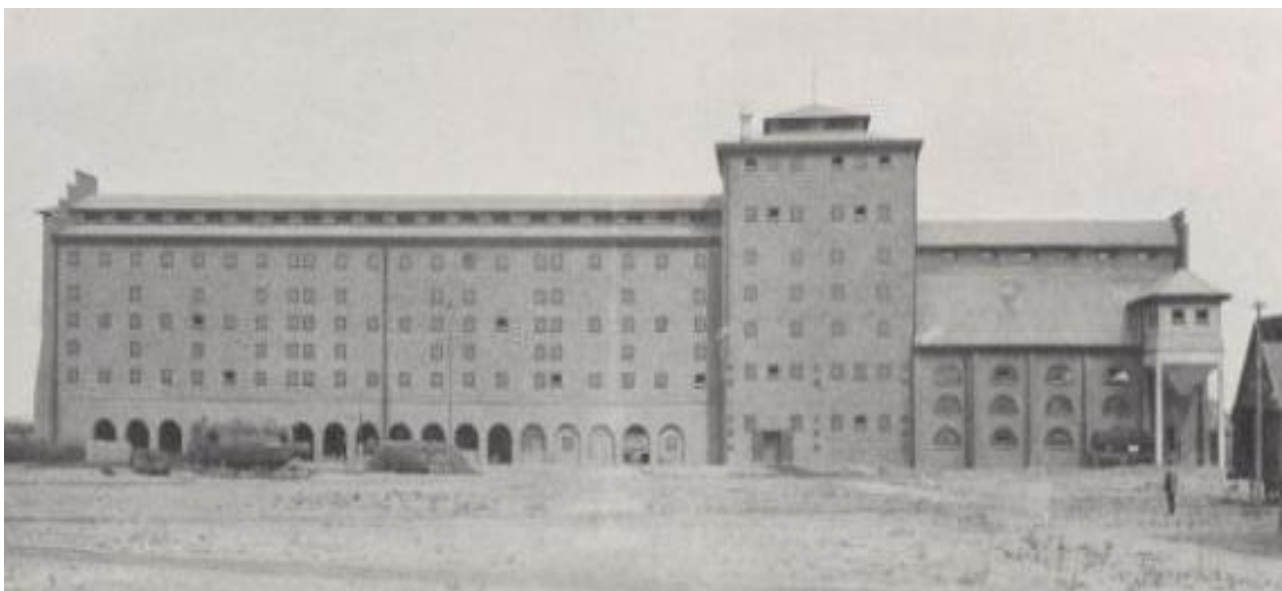
Fot. 44. Budynek fabryki kwasu siarkowego
