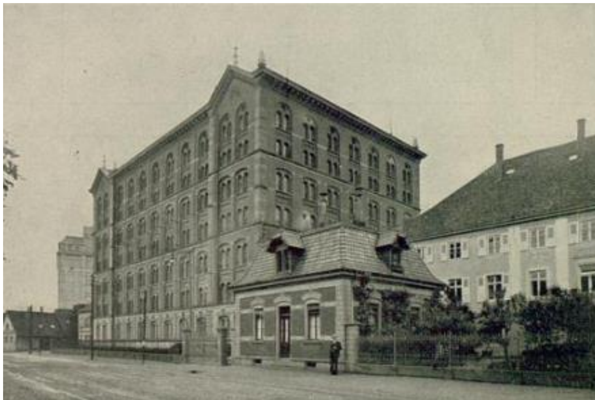
Fot. 69. Przemysłowa zabudowa należąca do przedsiębiorstwa rodziny Sinnerów, Karlsruhe, pocz. XX wieku Źródło: E. Sander, Karlsruhe einst und jetzt in Wort und Bild, Karlsruhe 1911 , s. 166.
