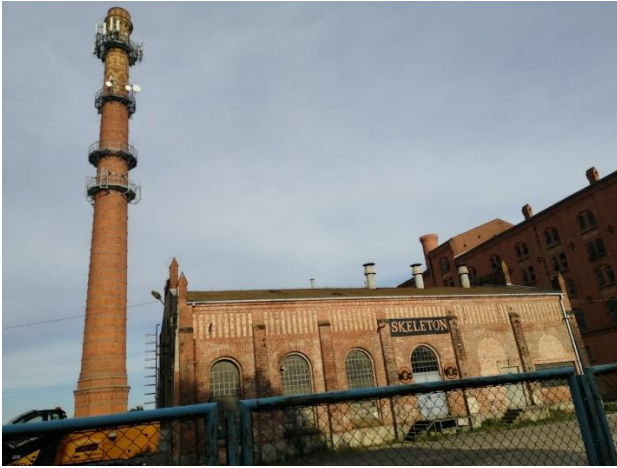
Fot. 48. Komin przy dawnej kotłowni rezerwowej Źródło: W. Terlecka, lipiec 2021.
