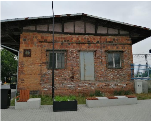
Fot. 62. Zabytkowy budynek szkoły Źródło: W. Terlecka, lipiec 2021.
