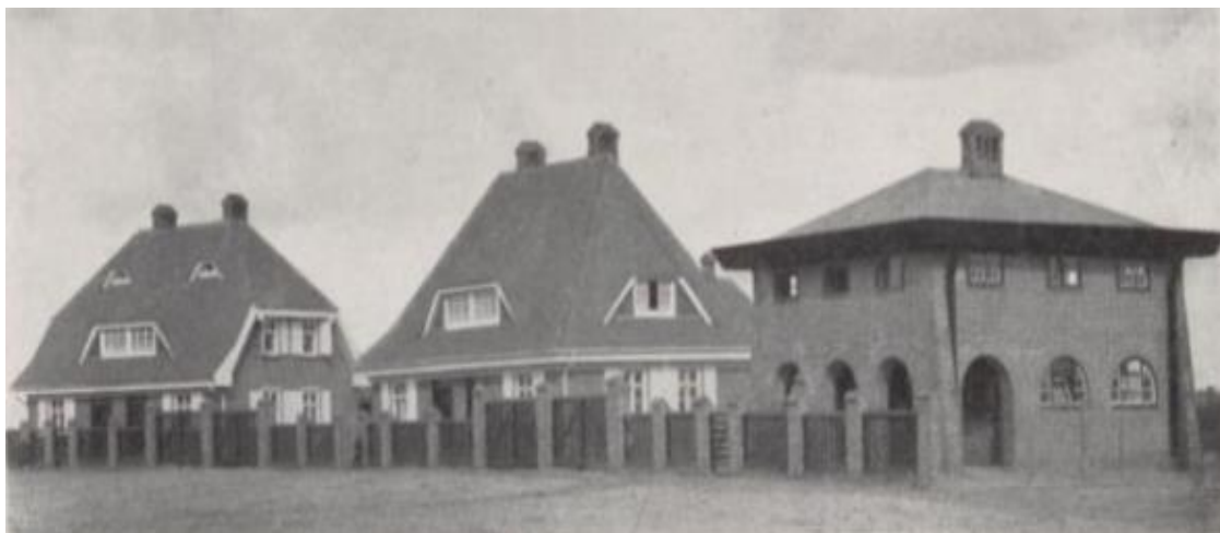
Fot. 66. Archiwalne zdjęcie zabudowań osiedla pracowniczego przy Fabryce Chemicznej M. Milch & Co Źródło: T. Heuss, op. cit., s. 87.
