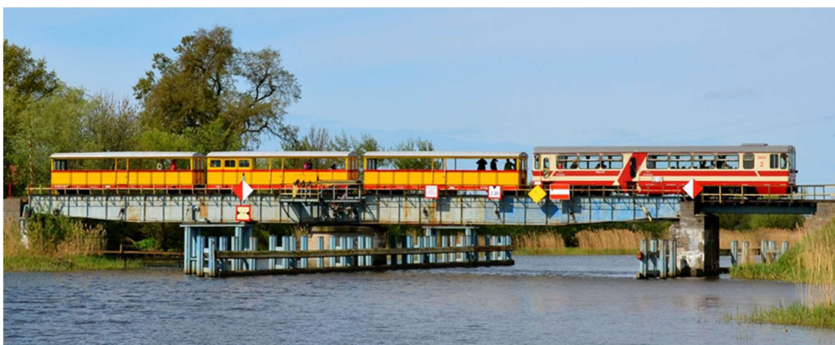
Fot. 2. Most obrotowy w Rybinie (na rzece Szarpawie) z 1906 r. stanowi element infrastruktury Żuławskiej Kolei Dojazdowej reaktywowanej przez Pomorskie Towarzystwo Miłośników Kolei Żelaznych.
