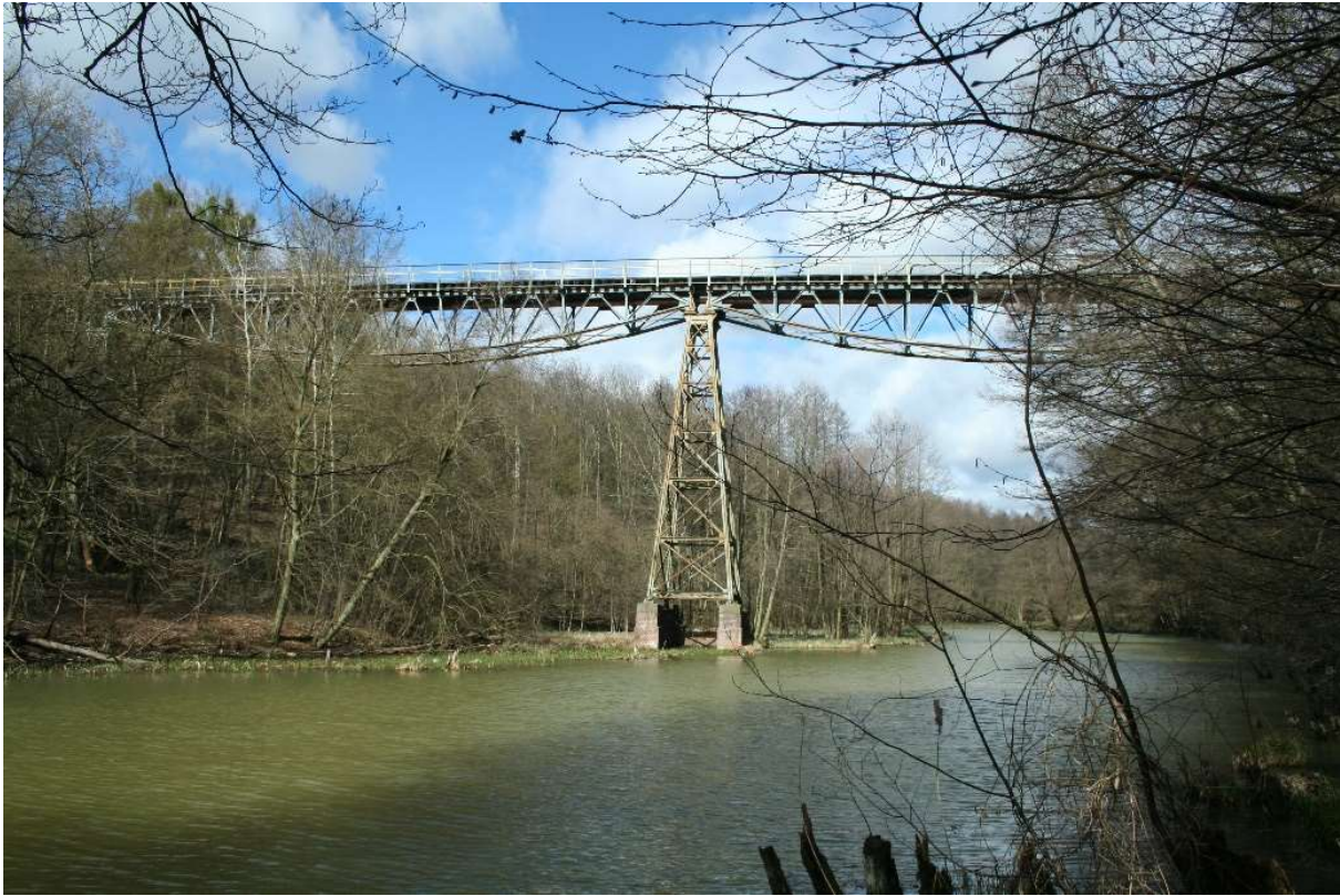
Fot. 1. Most kolei wąskotorowej na rozebranej linii Bydgoszcz Wąsk. – Koronowo, zbudowany w 1895 r. na terenie zaboru pruskiego.
