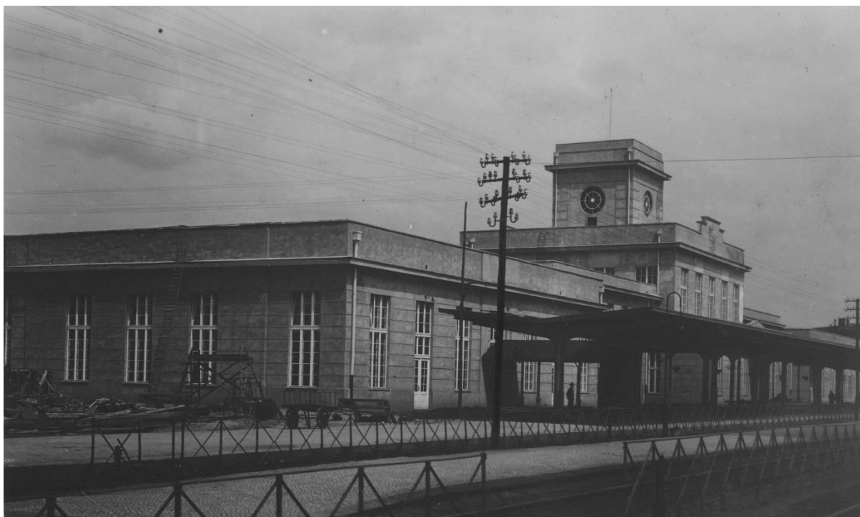
Budynek dworca kolejowego w Zbąszyniu podczas budowy – prace wykończeniowe, 1929. Źródło zdjęcia: Narodowe Archiwum Cyfrowe, https://www.szukajwarchiwach.gov.pl/en/jednostka/-/jednostka/5931391/obiekty/327075#opis_obiektu [odczyt: 19.09.2022].
