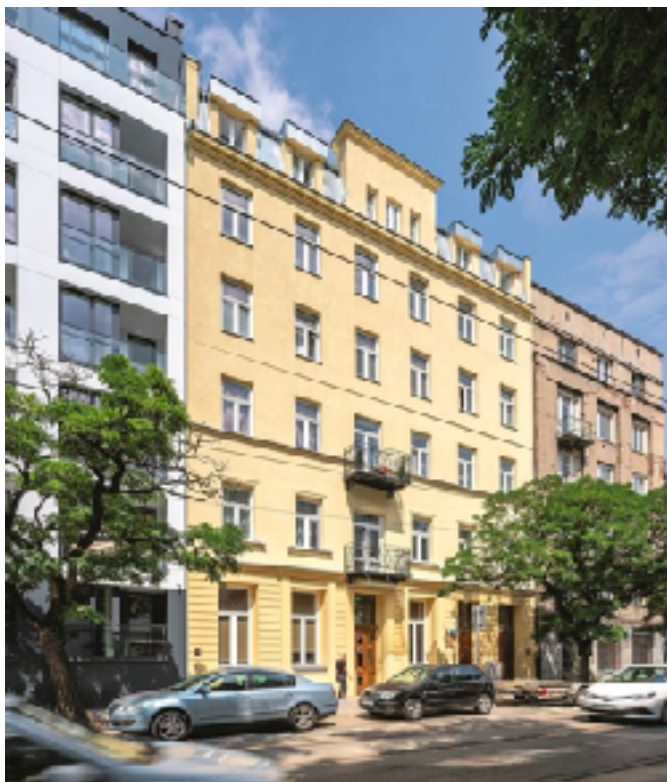
II.4. Widok na elewację kamienicy po przebudowie źródło: www.architektura.muratorplus.pl , (dostęp: 05.05.2023).
