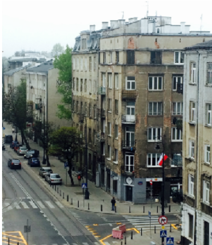
Il.1. Kamica przy ul. Stalowej 29, stan przed przebudową
