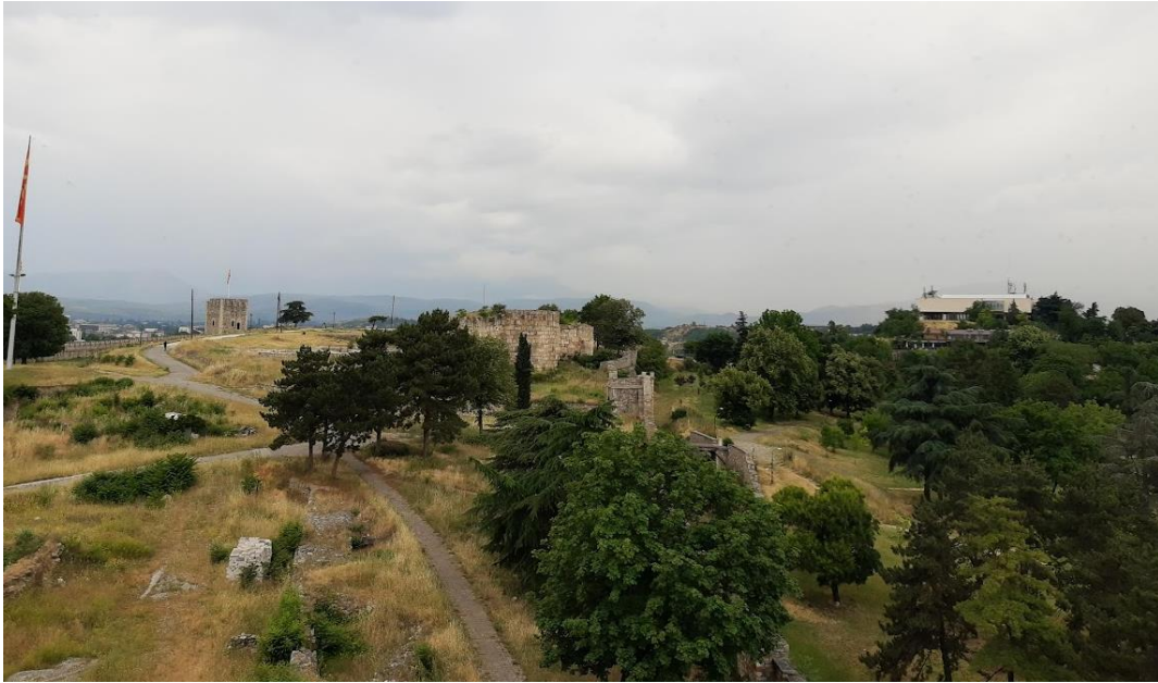
Ryc. 32. Widok na dziedziniec skopiańskiej fortecy („Skopje-Kale”), stan obecny (na rok 2021) (zdj. Autor).
