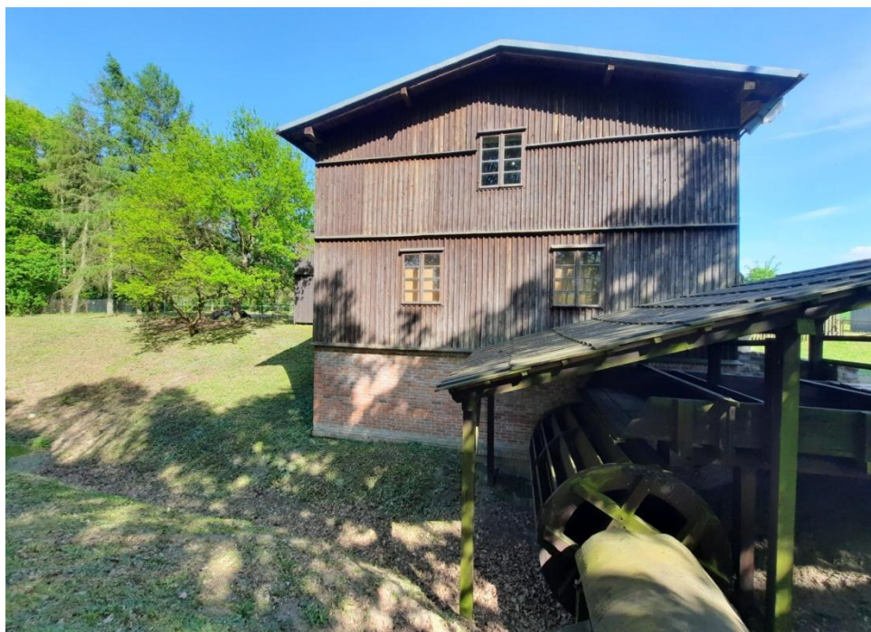
Fot. 4. Przykład młyna z kołem nasiębiernym w Wielkopolskim Muzeum Etnograficznym w Dziekanowicach (fot. M. Stępnia-Lis).
