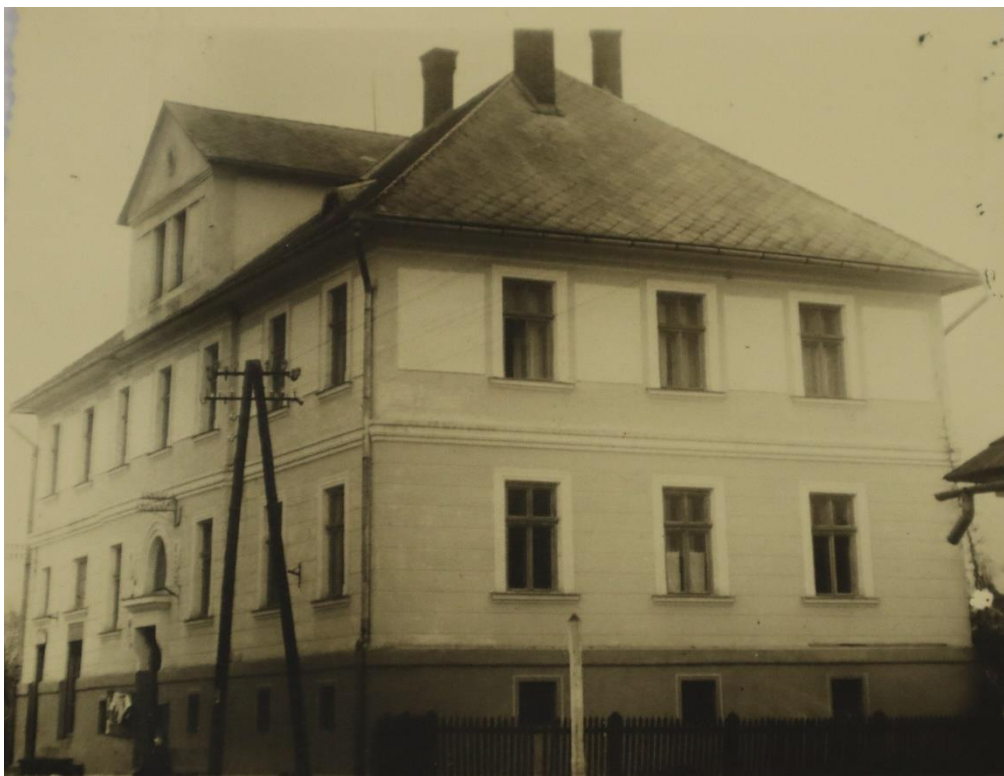
Budynek urzędu notariusza gminnego w Jabłonce
