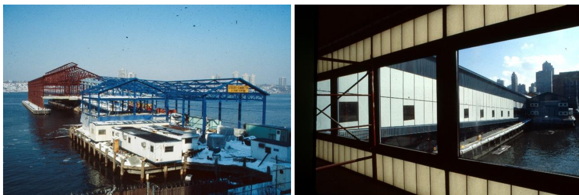
157. Budowa stacji przeładunkowej przy 59th Street.
