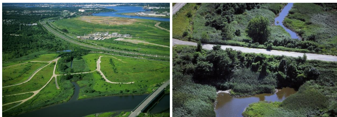
167. Miejsce w Fresh Kills wybrane na Landing .
