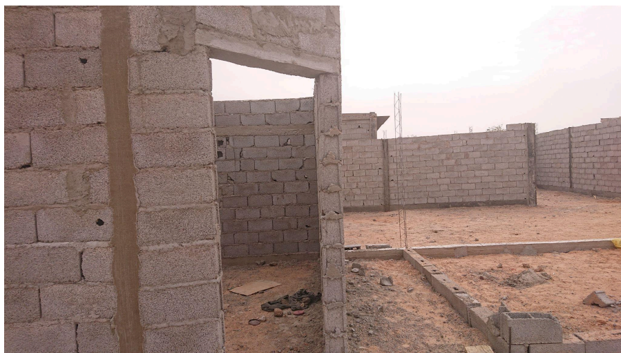
Rys. 8. Budowa nowych, bardziej stabilnych domów. Obóz Smara.
