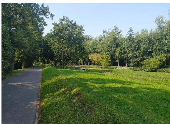
Fot. 9. Wał przeciwpowodziowy Autor: D. Abramowicz
