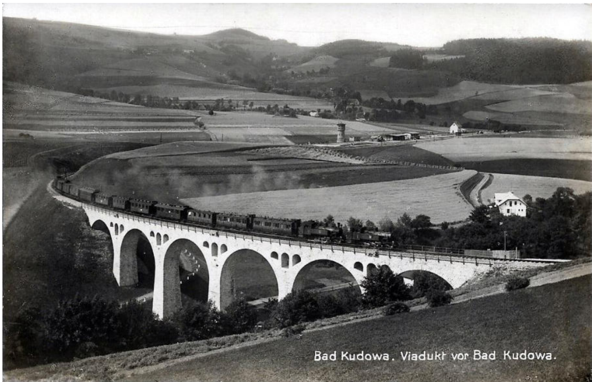
Ryc. 10 Wiadukt kolejowy w Lewinie Kłodzkim, pocz. XX wieku. Źródło: materiał z grupy „Stołowogórzanie” na portalu społecznościowym Facebook.
